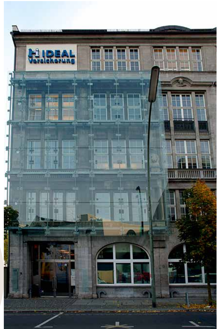
Die alte IDEAL-Hauptverwaltung von der Zimmerstraße aus betrachtet nach der Fassadensanierung 2003.
